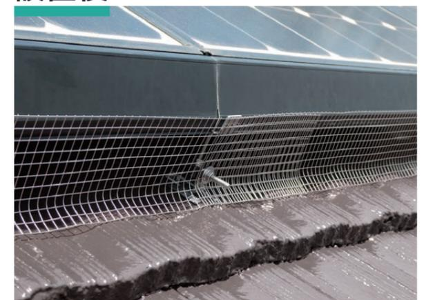
柔軟性のある特殊なフェンスはマス目10mm。凹凸のある屋根にもフィットさせることができ、専用取付金具でしっかり設置することで鳥の侵入を許しません。パネル新設のタイミングで予防として設置いただければ安心です。既設パネルへの後付設置も可能です。
