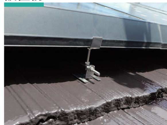
太陽光パネルと屋根の隙間は、ハトなどの鳥にとっては雨風や天敵から逃れる格好の場所です。鳥は数センチ程度の隙間があれば侵入が可能で、侵入してしまった場合は営巣、糞害、ケーブル損傷・腐食等が起こってしまいます。
