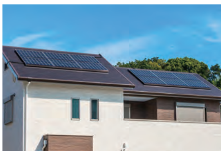
図面がない場合は配置が完全にわかる現場写真を撮影
